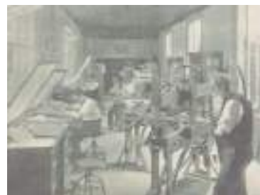
Sala de transferencia de planchuelas a rodillos
