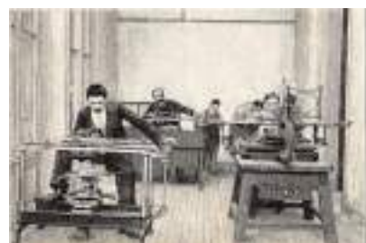
Sala de pantógrafos.
